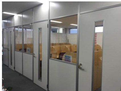
先日は学習塾様でのパーティ ション工事をさせて頂きました
