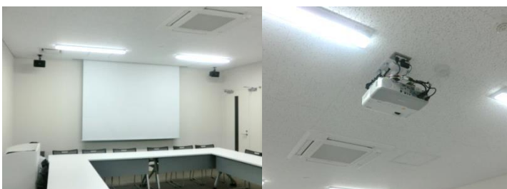
会議室のプロジェクタの天吊・スクリーン設置工事もさせて頂きました
